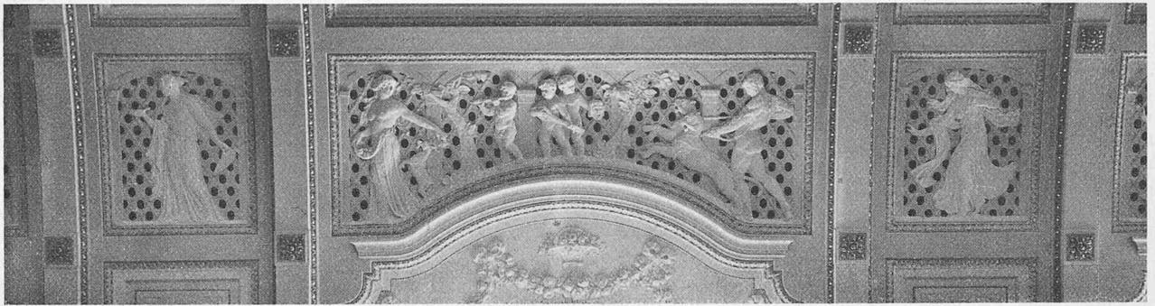
Abb. 9. Lüftungsgitter im grossen Konzertsaal des neuen Berner Casinos. — Architekten: Lindt & Hofmann.
