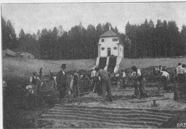
Abb. 23. Abdichtung der Weihersohle (September 1909).
