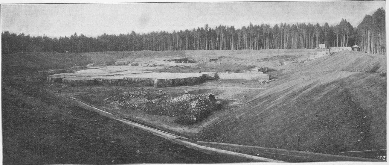
Abb. 22. Aushub des Weihers im Oktober 1907. Blick von der südlichen Weherecke aus.
