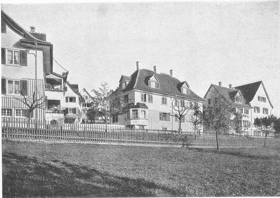
Blick auf die untern Doppelhäuser von der projektierten Strasse B nach Osten
