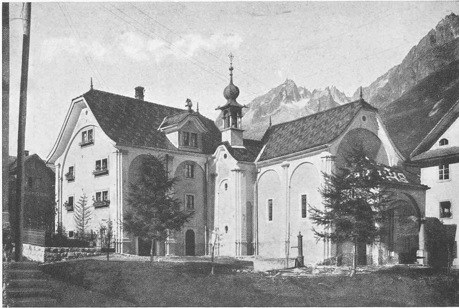
KAPLANEI UND KIRCHLEIN ZU ST. KARL IN HOSPENTHAL — ERBAUT 1718
