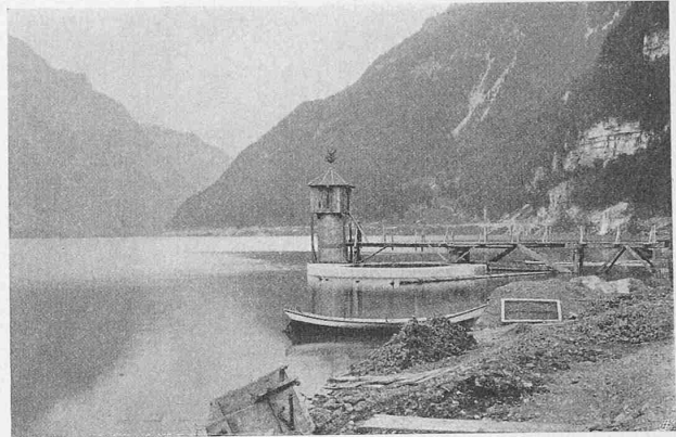
Abb. 23. Einsteigturm und Ueberfallkrone der II. Periode (31. Juli 1909).
