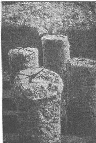
Simplexbetonpfähle
