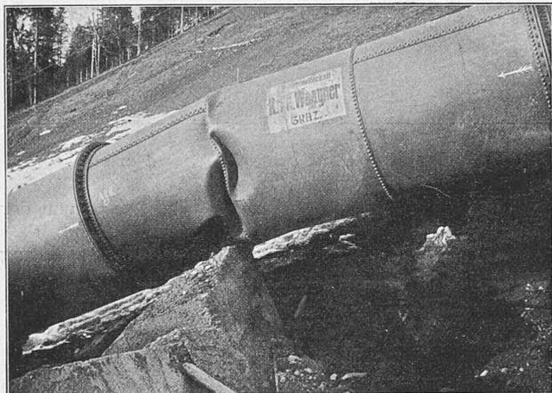
Abb. 28. Untere Knickung des Rohrstranges links.
