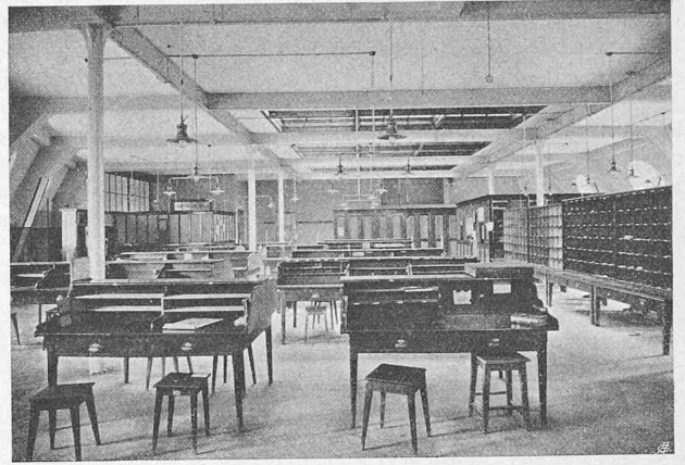
Abb. 11. Briefträgersaal im Dachgeschoss.
