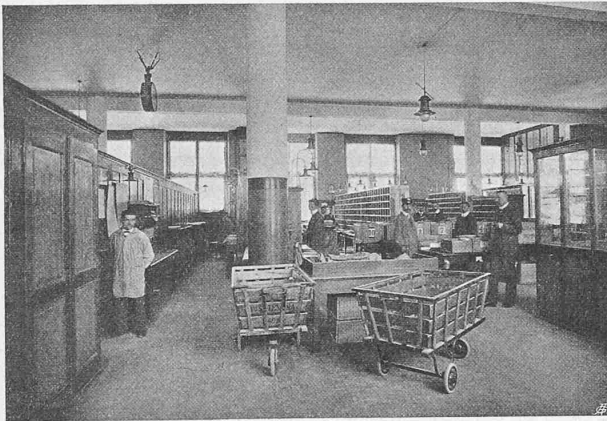
Abb. 9. Postbureau im Erdgeschoss.
