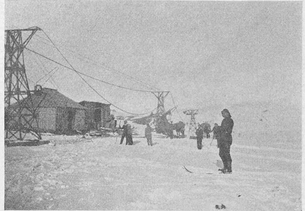
Abb. 5. Montage der Anlage im Winter 1908/1909.
