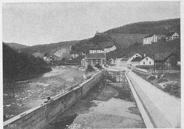
Abb. 26. Oberwasserkanal und Maschinenhaus. (30. März 1909.)
