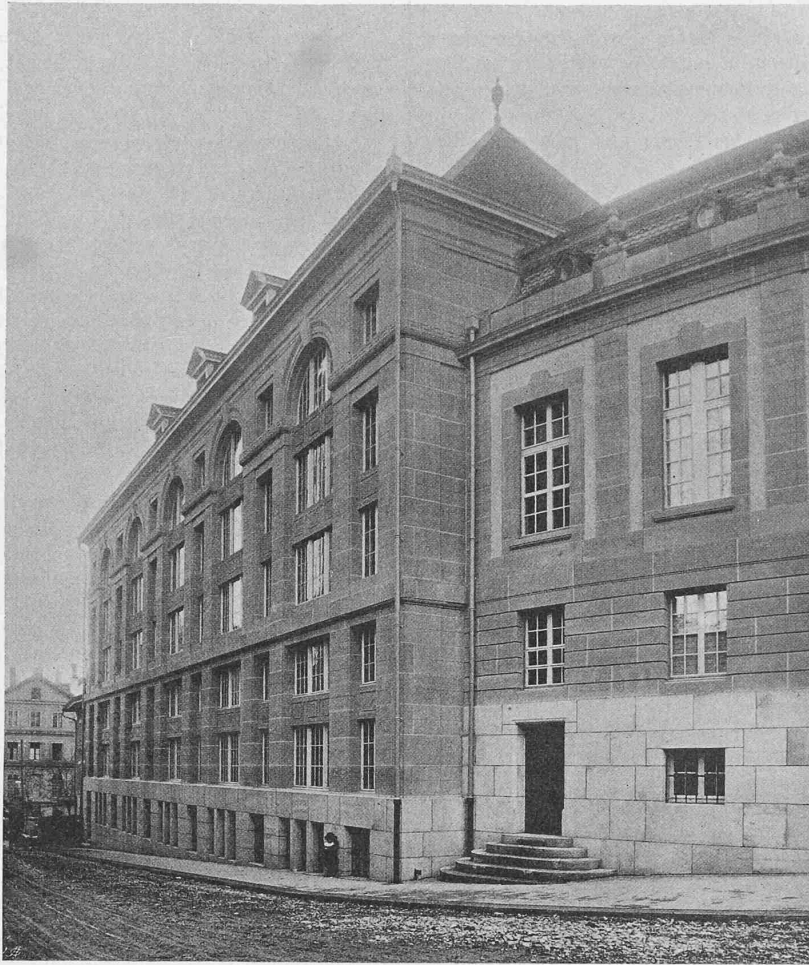
Fig. 4. Bâtiment des magasins des livres.
