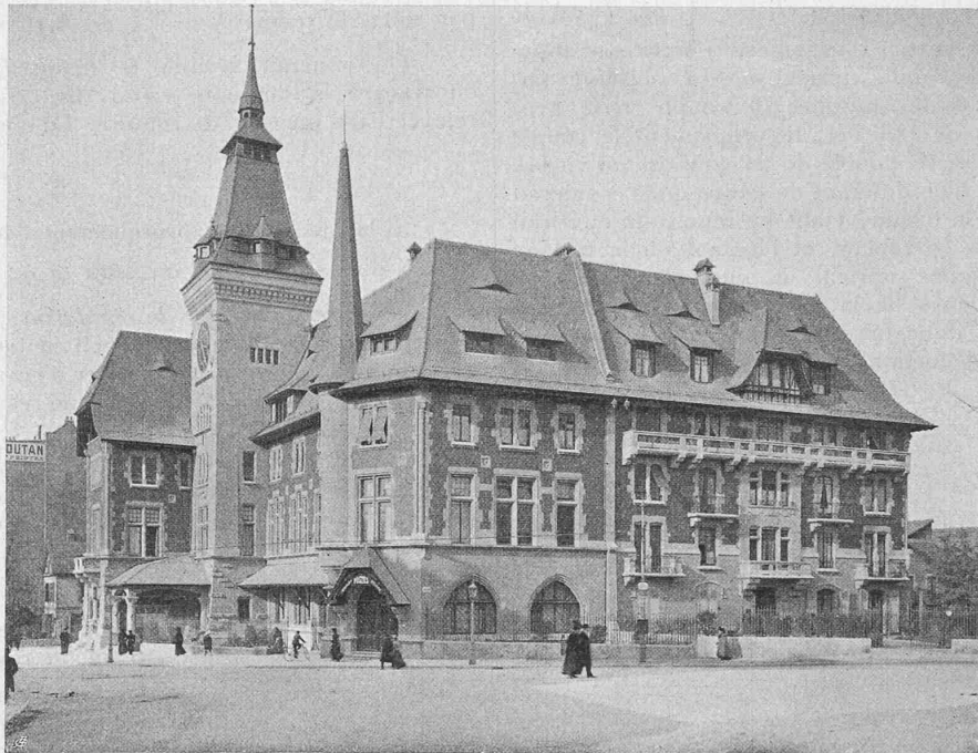
Abb. 4. Fassade gegen die Route de Frontenex.
