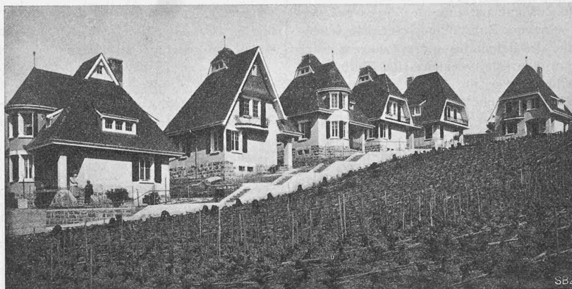
Abb. 6. Gesamtansicht der Kolonie Montgibert von Südosten.
