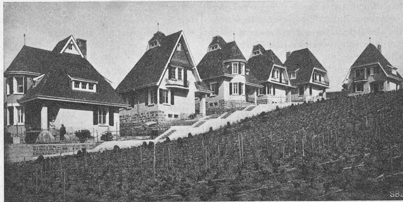
Abb. 6. Gesamtansicht der Kolonie Montgibert von Südosten.
