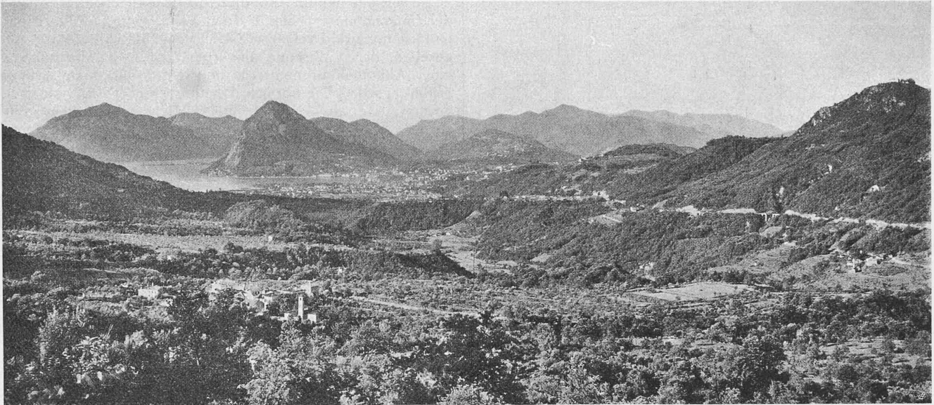
Abb. 3. Blick von Dino talauswärts in südlicher Richtung; rechts das Bahntracé Lugano-Tesserete.
