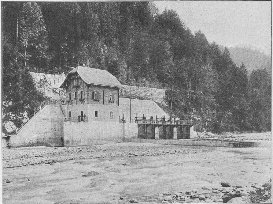
Abb. 9. Ansicht der Wasserfassung in der Bregenzer Ach unterhalb Bezau.
