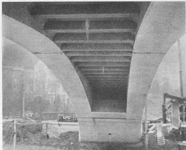
Abb. 18. Untersicht der vollendeten Brücke.
