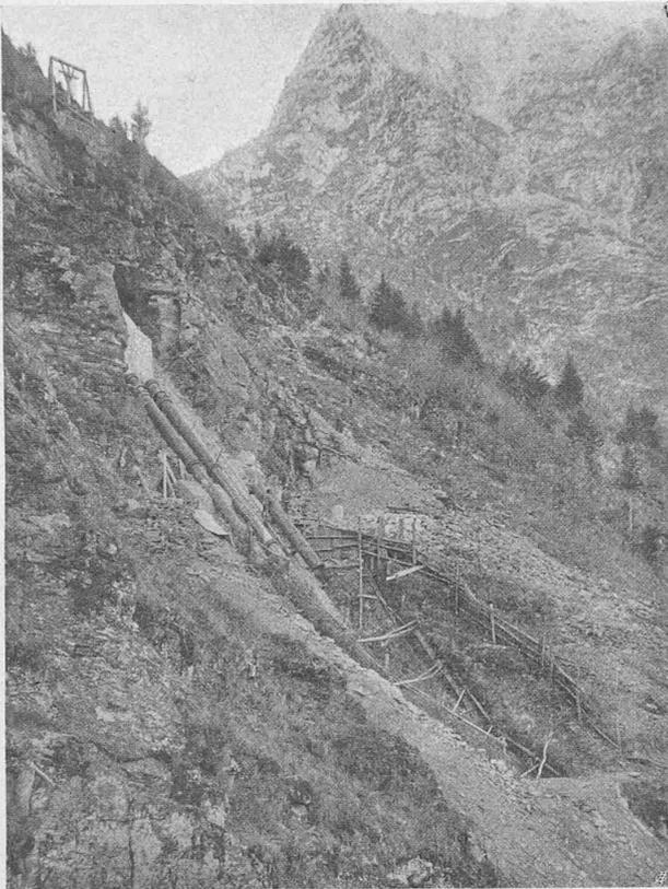
Abb. 10. Rohrleitung unterhalb Fixpunkt III.
