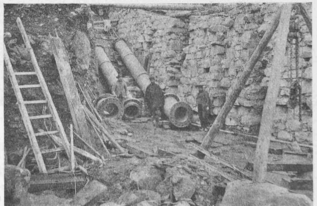
Abb. 13. Fundamente im Fixpunkt I bei der Zentrale.
