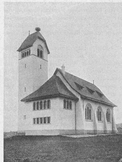
Abb. 1. Ansicht von Nordost.
