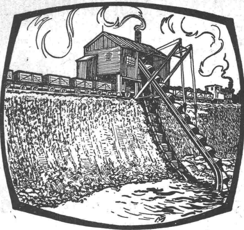
3 Löffelbagger 2 Eimerkettenbagger } z. Zeit in der Schweiz im Betrieb.
