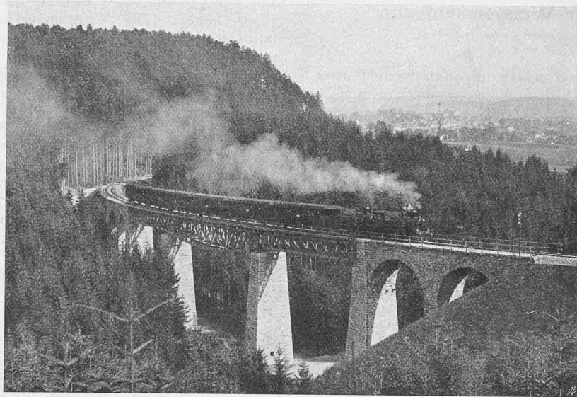
Abb. 4. Geissloch-Viadukt von N.-W., im Hintergrunde die Stadt Solothurn.
