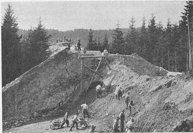
Abb. 17. Rückseite der gerissenen Flügelmauer links (Abb. 16).
