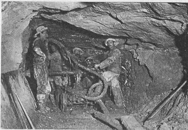
Abb. 23. Bohrwagen vor Ort der Südseite.
