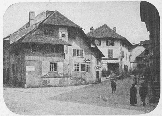
Abb. 9. Das alte Gugelmannhaus in Murten.
