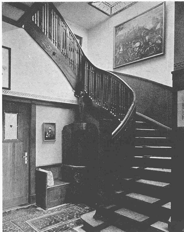
BASLER FAMILIENHÄUSER ERBAUT VON ARCHITEKT A. ROMANG IN BASEL
