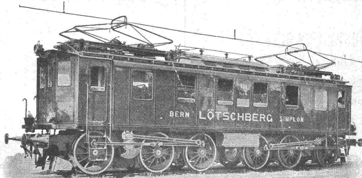
2000 PS Einphasenlokomotive der Lötschbergbahn.
