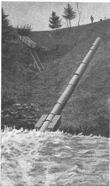
Automatischer Saugüberfall in Gibswil (Kanton Zürich).
