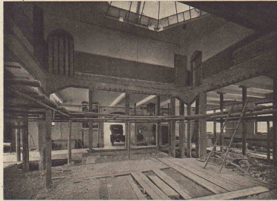
14. Utoqrage in Zürich V. Ausstellungshalle. Verstärkung bereits ausgeführter Eisenbetonkonstruktion
