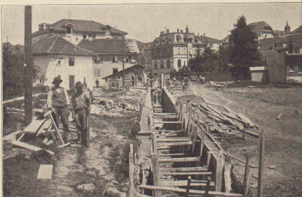
11. Kanalisation in Wil (Kt. St. Gallen). Ueberdeckung und Brücken aus Eisenbeton
