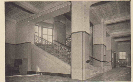
17. Schulhaus in Zürich IV an der Riedlistraße. Ansicht der Treppenanlage
