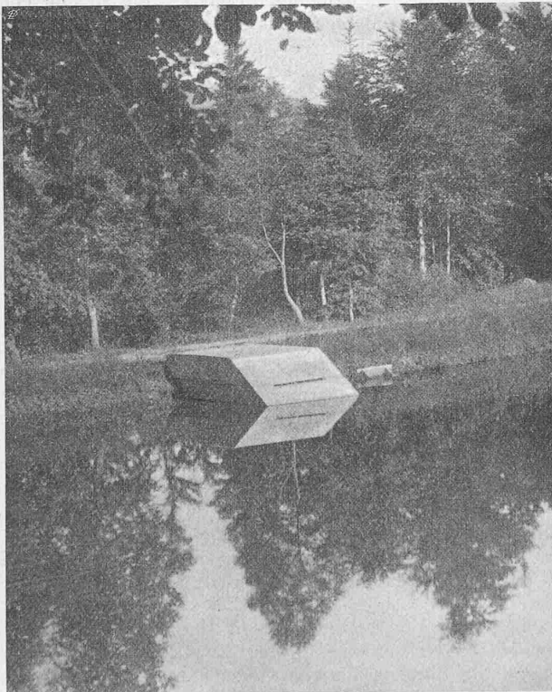
Abb. 14. Einlauf des Saugüberfalles in Gibswil.
