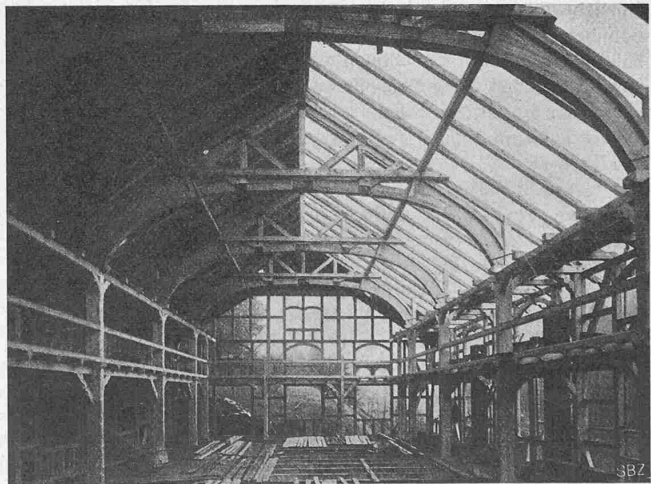
Abb. 15. Hetzersche Fachwerk-Binder, Turnhalle Ziegenrück.
