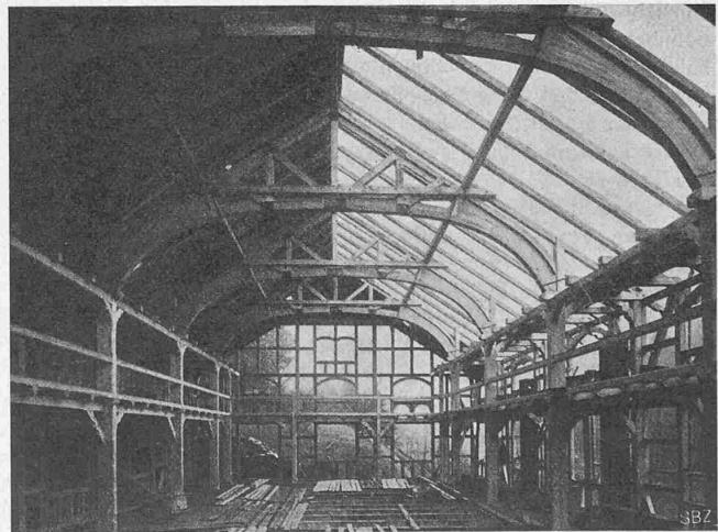
Abb. 15. Hetzersche Fachwerk-Binder, Turnhalle Ziegenrück.
