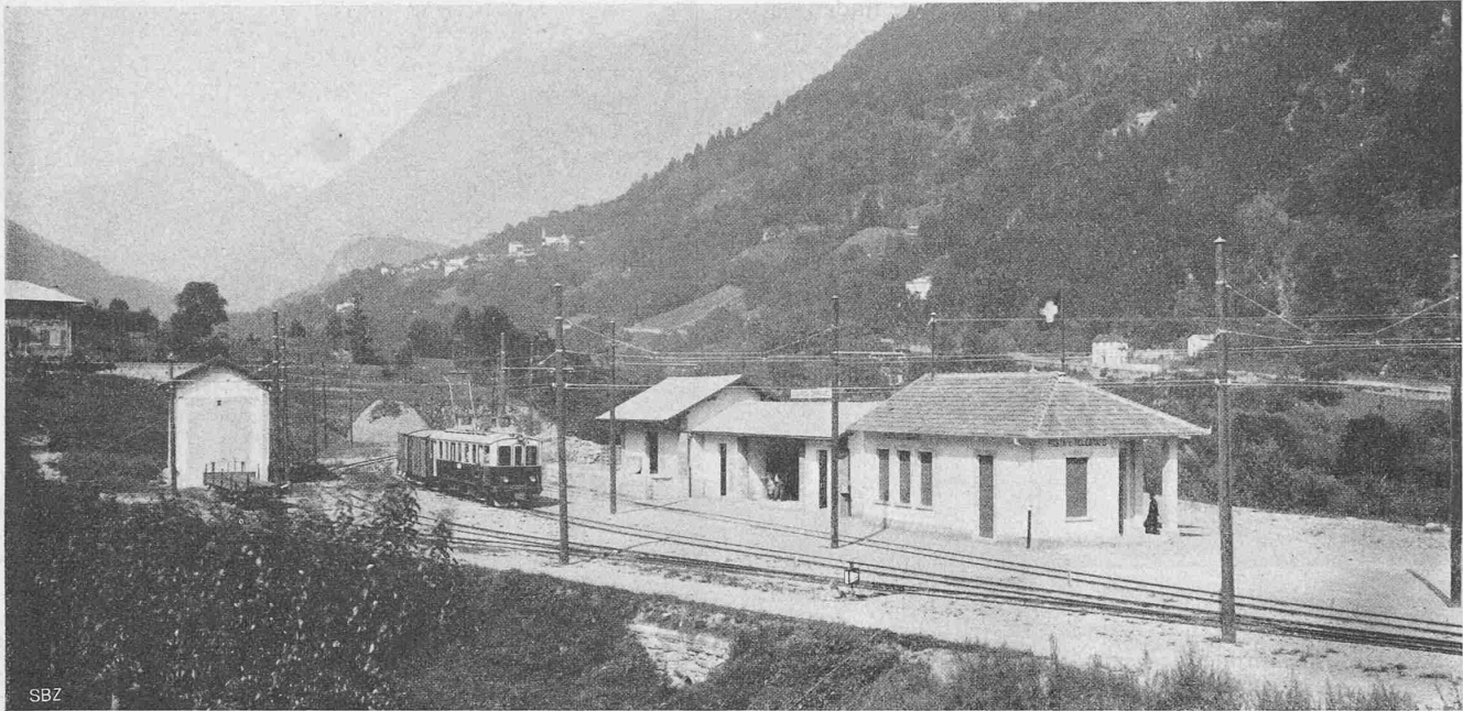
Abb. 10. Ansicht der Station Comprovasco (Acquarossa).
