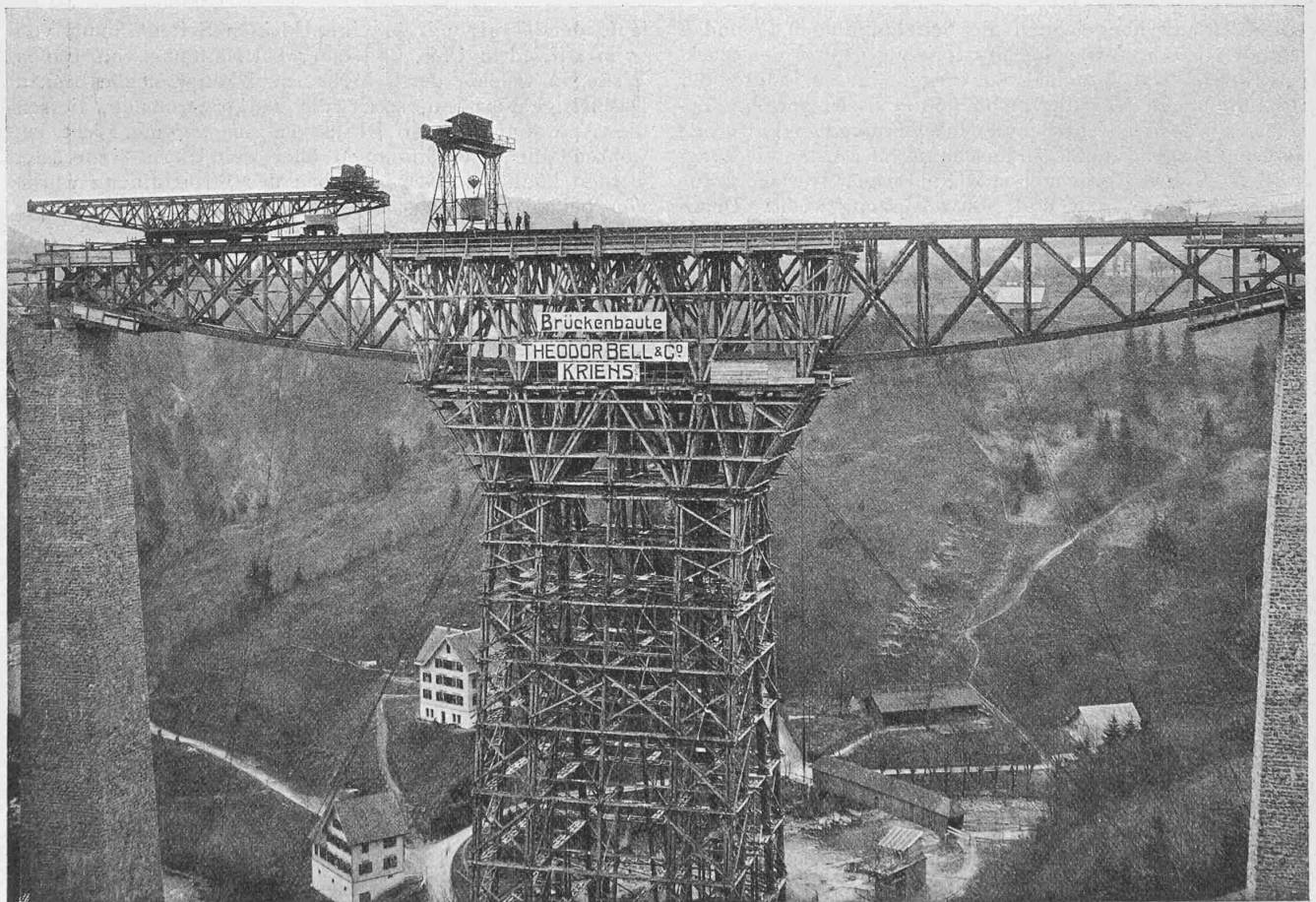
Abb. 19. Oberer Teil des Gerüstturms mit Hubkran und Auslegerkran zum freien Vorbau des Eisenträgers des Sitterviaduktes der B. T.
