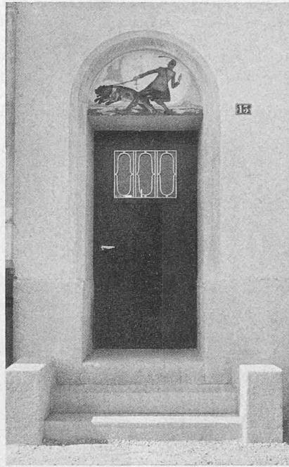
Abb. 4. Hauseingang an der Stahlwerkstrasse.
