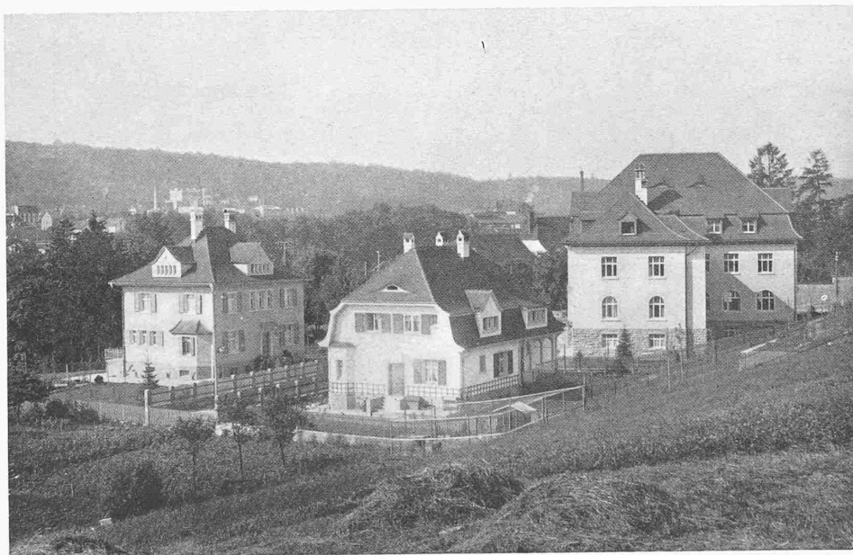
Gesamtbild der Baugruppe von Norden
