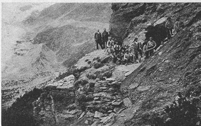
Abb. 43. Untere Stollenmündung des Palü-Tunnels (Km 28,125).
