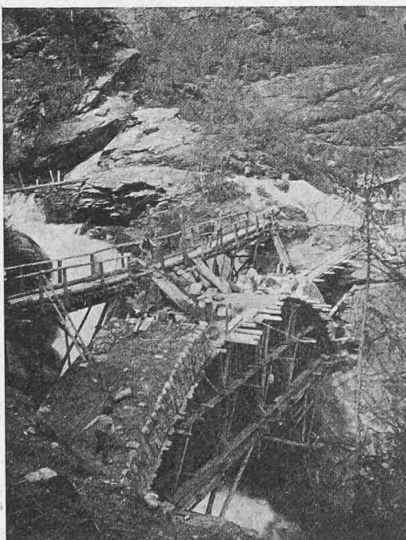
Abb. 49. Obere Cavagliascobrücke mit seitlichem Dienststeg.
