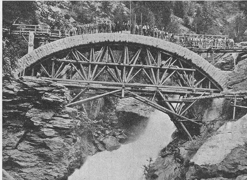
Abb. 50. Eingewölbte obere Cavagliasco-Brücke.
