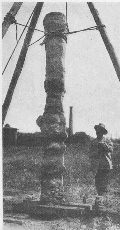
Abb. 1. Ausgegrabener Strausspfahl.
