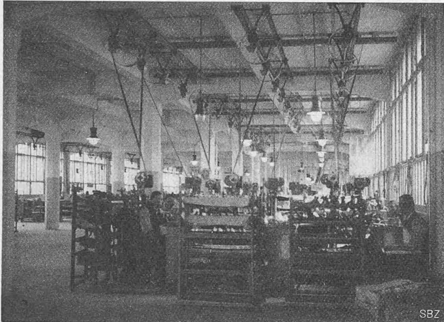
Abb. 21. Arbeitsaal mit Pressgas-Beleuchtung im III. Stock.
