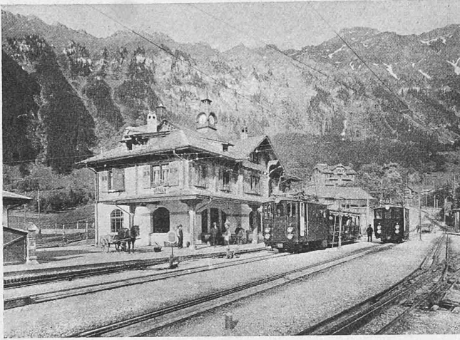
Abb. 34. Elektrische Lokomotive auf der Station Wengen.
