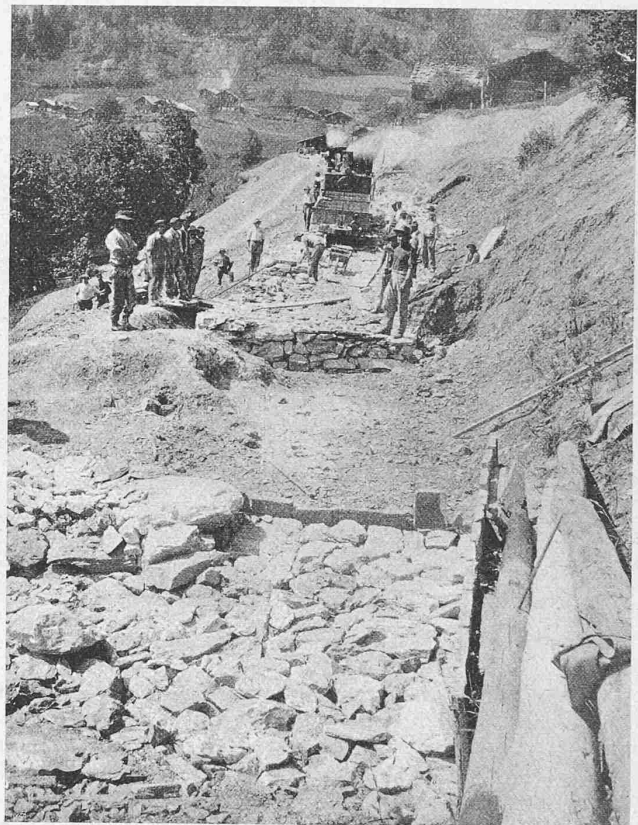
Abb. 33. Bahnkörper mit Sickerschächten bei Km. 3,0.
