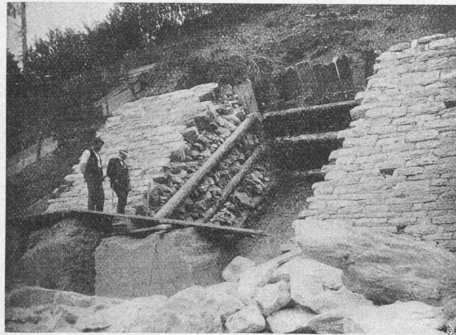
Abb. 31. Rekonstruktionsarbeiten bei Km. 2,47.
