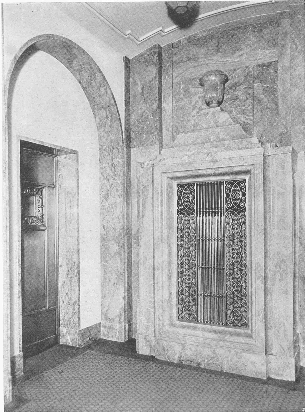
Heizkörperverkleidung im Treppenhaus
