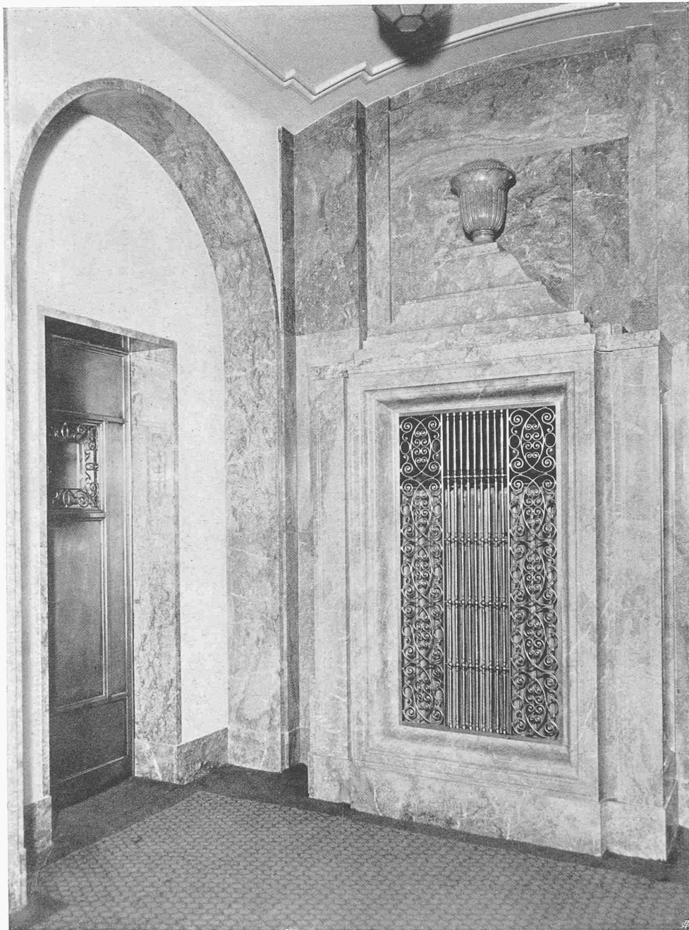
Heizkörperverkleidung im Treppenhaus
