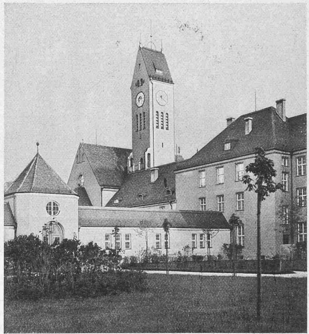
Abb. 13. Kirche mit Hof im Krankenhaus Schwabing.
