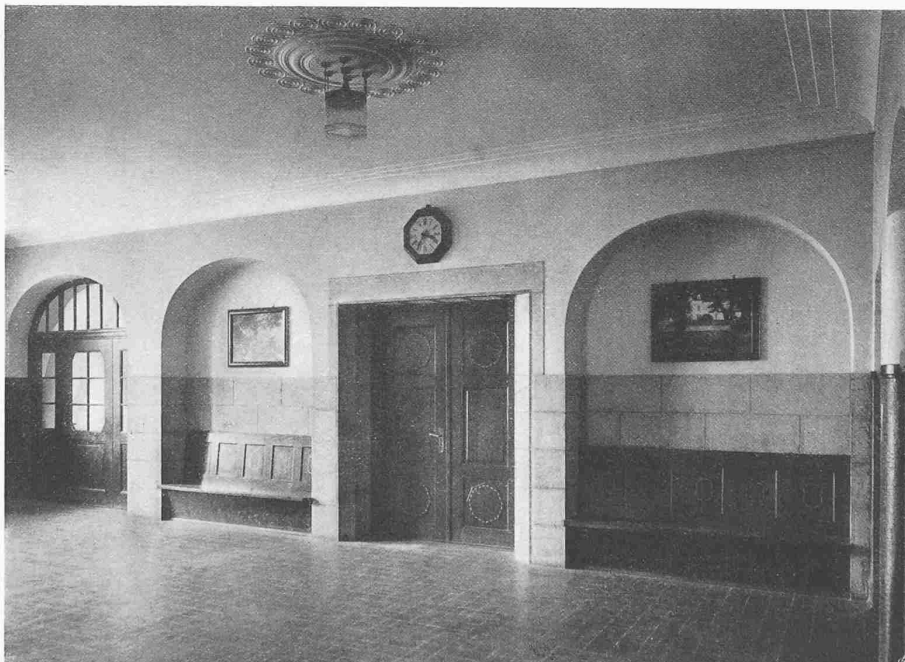
Treppenvorplätze im Erdgeschoss und I. Stock
