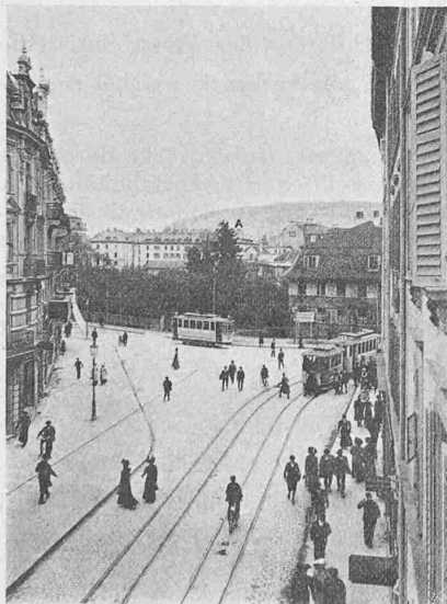
Abb. 2. Blick von Punkt B, Ecke Bleicherweg und Tödistrasse gegen A (Bärengasse Nr. 32).
