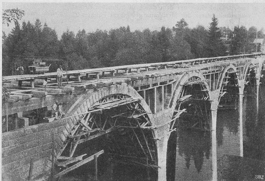
Abb. 9. Aufmauern der Verkleidungswände, Versetzen der Siegwartbalken. 3. IX. 1912.
