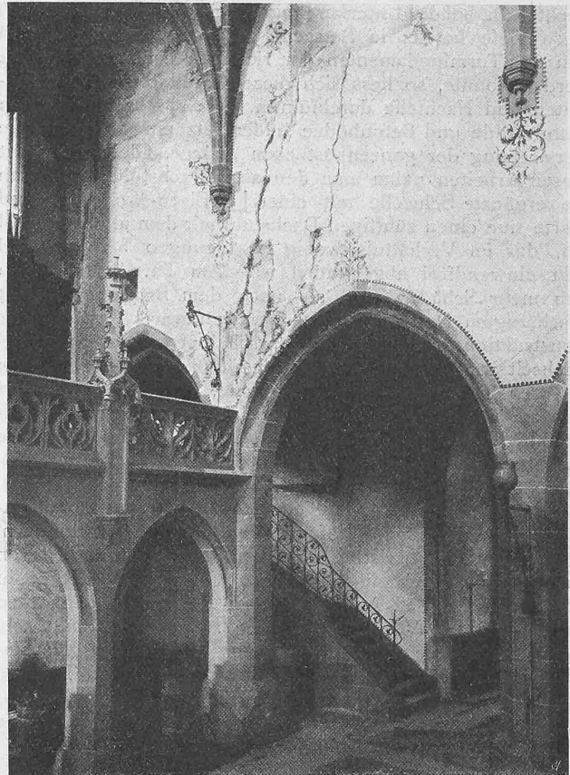
Abb. 17. Risse in der nördl. Längswand des Mittelschiffes. (Schnitt-Ebene a-b in untenstehender Abb. 20.)
