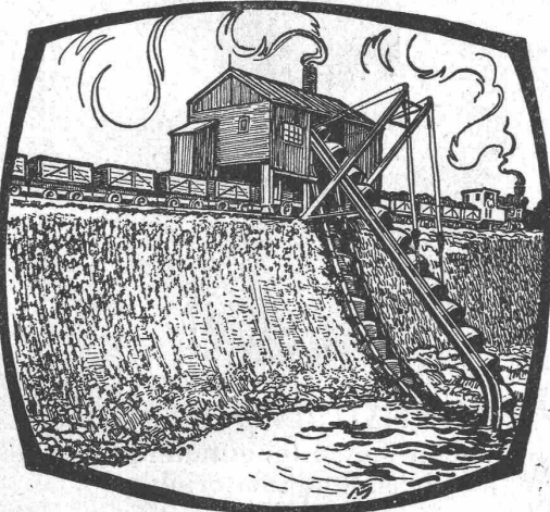
3 Löffelbagger } zur Zeit in der Schweiz 2 Eimerkettenbagger } im Betrieb.
