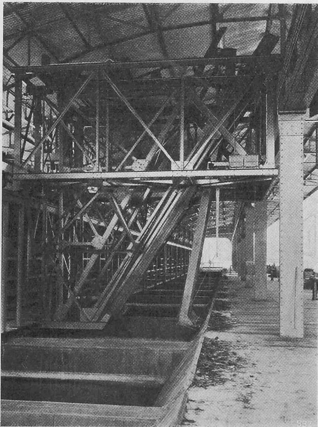
Abb. 9. Mechanische Rechenreinigungs-Vorrichtung.
