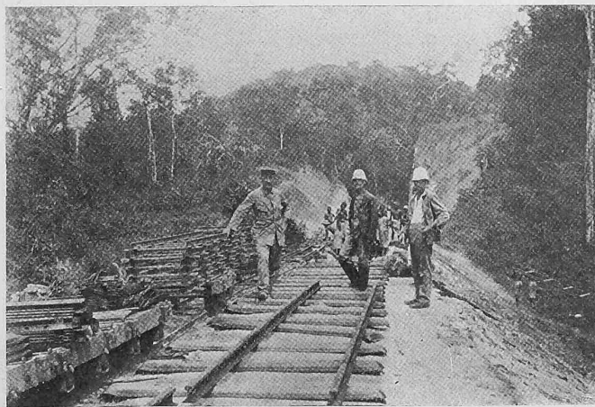
Abb. 15. Vorstrecken des Geleises.
