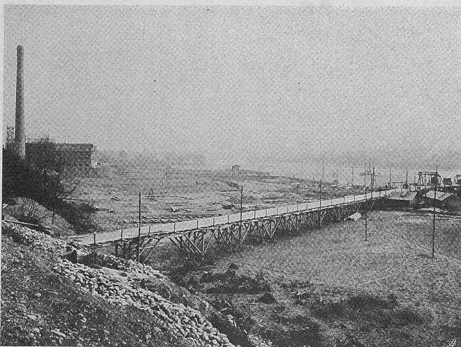
Abb. 80. Die Baustelle mit Dienstbrücke zum Stauwehr (I. XII. 08).
