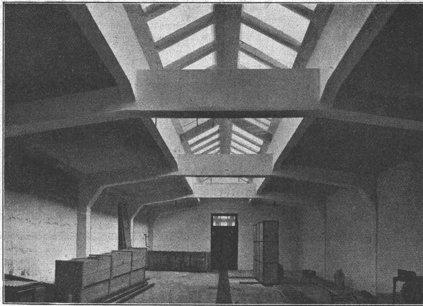
Färberei-Neubau in Eisenbeton.
