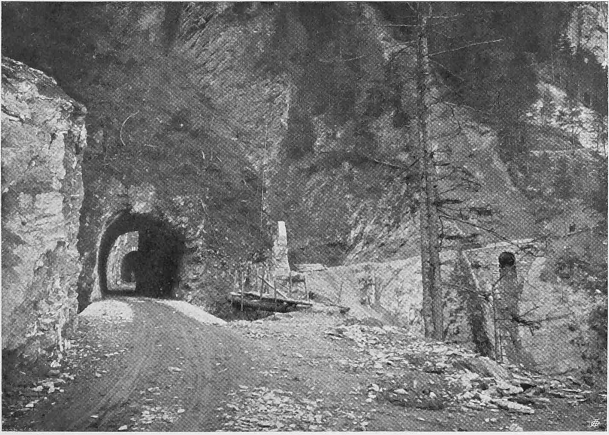
Abb. 9. Im Val da Schais (Km. 8 bis 8,4).
