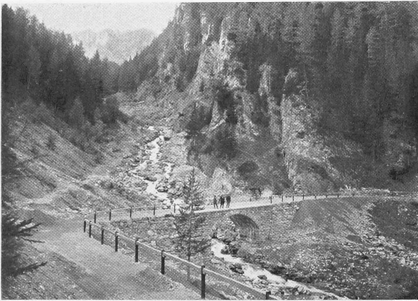
Abb. 13. Brücke im Val Sampuoir (Km. 13,4).
